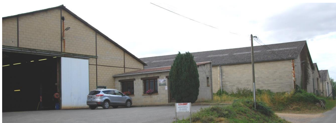
Secteur de l'ancienne conserverie
